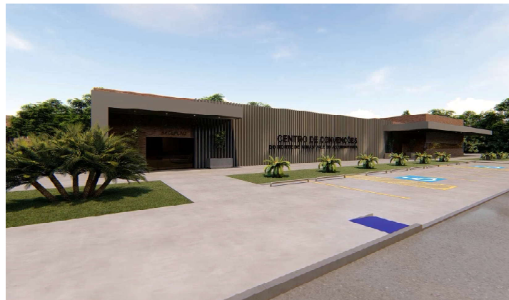
Projeto da nova sede do Cimams que está sendo construída com previsão de inauguração neste ano
